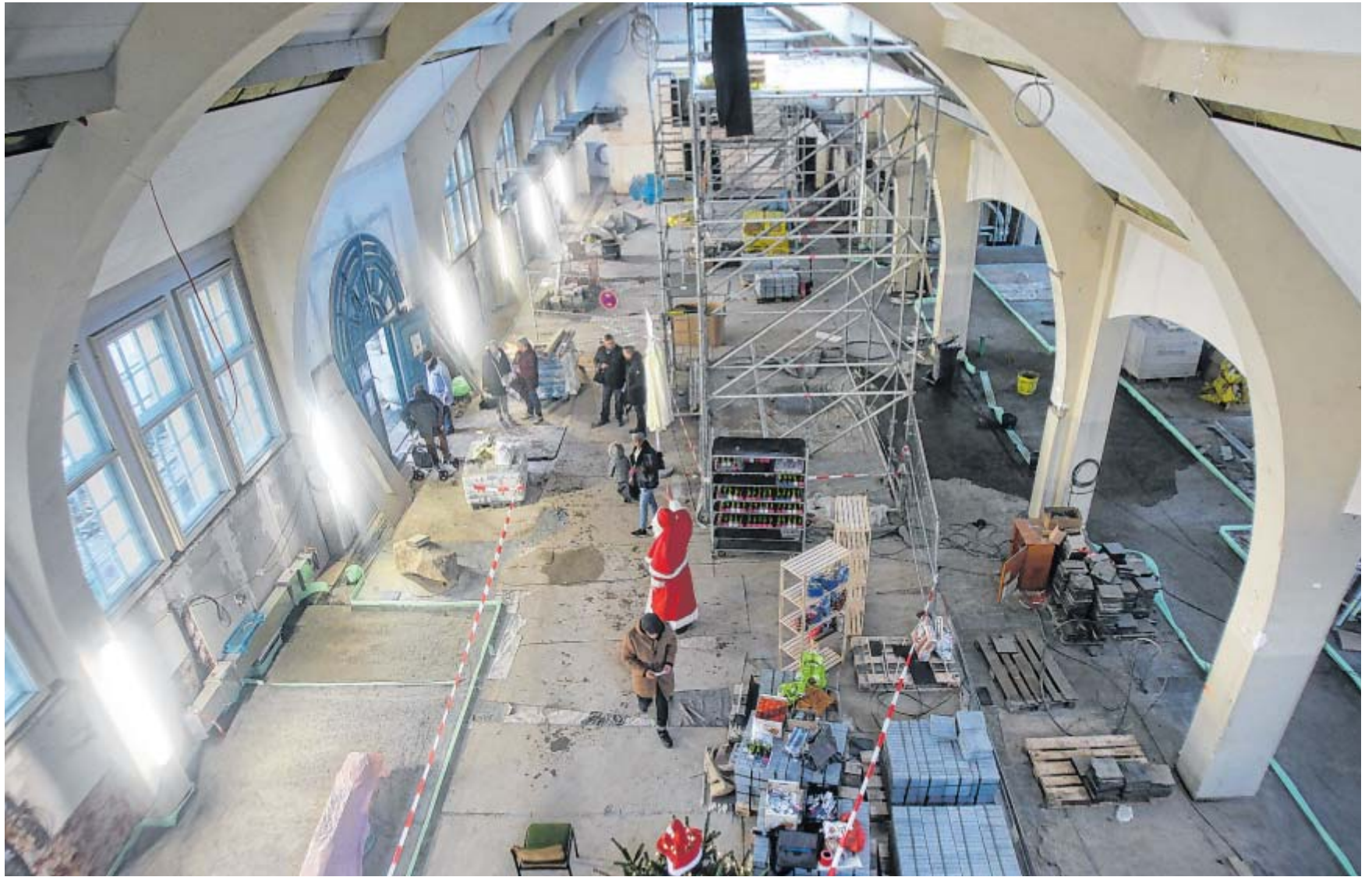
Baustelle: Marktbesucher konnten am Samstag einen Blick in die Baustelle der großen Markthalle werfen und Fragen stellen. Der Weihnachtsmann verschenkte Hyazinthen an die Besucher. FOTOS: KIEL-STEINKAMP
