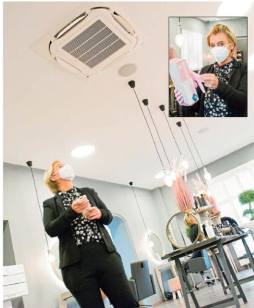
Sabrina Poser blickt an die Decke des Friseursalons. Hinter der Blende arbeitet eine Luftfilteranlage, dazu sollen viel Platz und regelmäßiges Lüften den Friseurbesuch sicher machen. Dazu tragen auch die Kunststoff-Handschuhe (kleines Foto) bei – deren Preis sich zuletzt fast vervierfacht hat. FOTOS: RALF BITTNER
