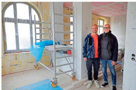
Matthias und Lars Uhlen lassen die Villa auch im Inneren aufwendig sanieren.
