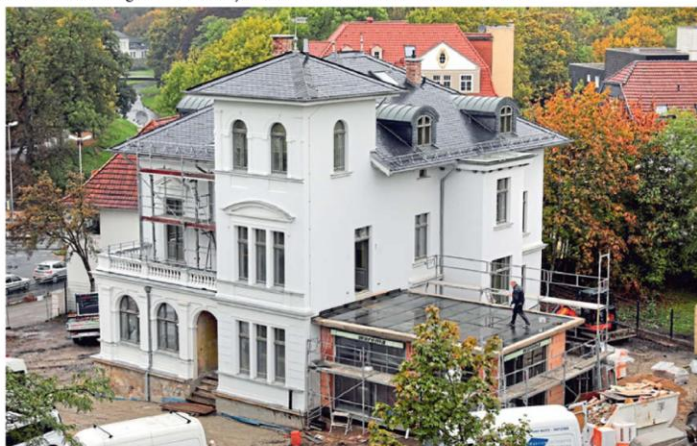
Die grau-grün gestrichenen Holzfenster setzen einen denkmalgerechten Akzent zum weiß gestrichenen Haus im Stil italienischer Landhausarchitektur. Rechts entsteht ein Wintergarten. FOTOS: FRANK-MICHAEL KIEL-STENKAMP
