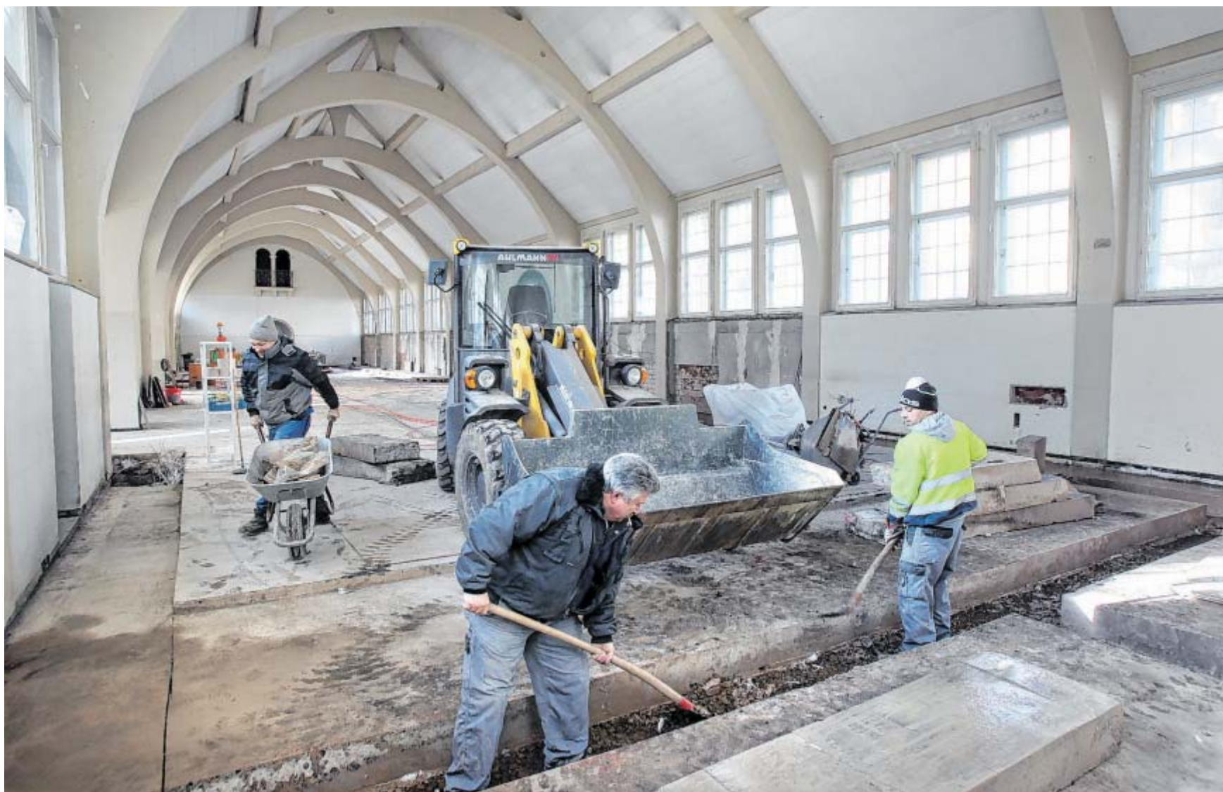
Legen eine Schütte zu: Die Arbeiten in der Herforder Markthalle sind in vollem Gange. Läuft alles nach Plan, verwandelt sich das historische Gemäuer bis zum ersten Quartal des kommenden Jahres in einen „Ort für Genießer“.
