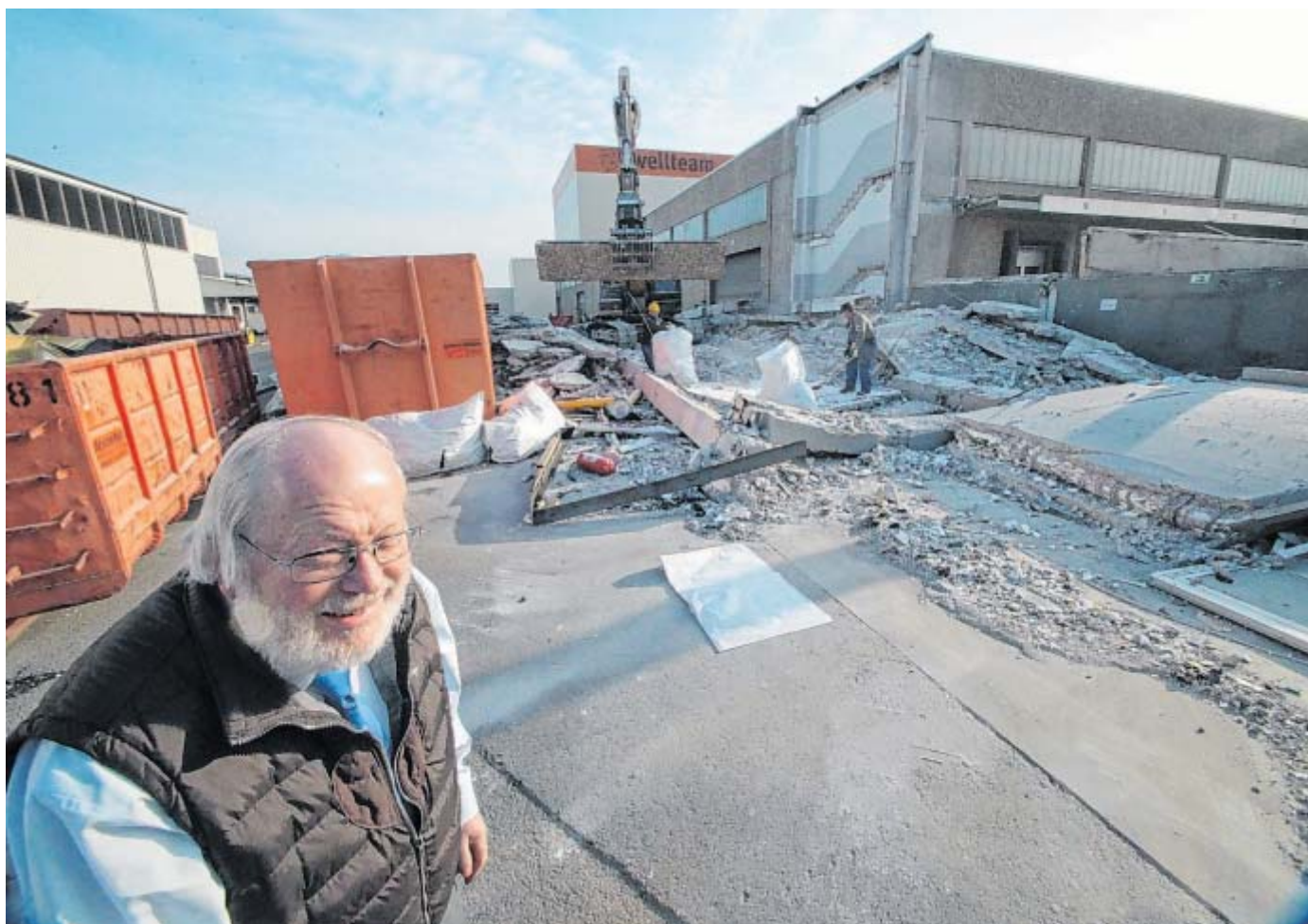
Umbau: Seniorchef Friedrich-Wilhelm Schönberg vor dem ehemaligen Auslieferungslager des Logistikere UPS. Seit Mitte Januar nutzt Wellteam die Halle als Halbfertigwaren- und Zwischenlager, Blocklager für Paletten sowie als Leerpalettenlager. FOTOS: PETER STEINERT
