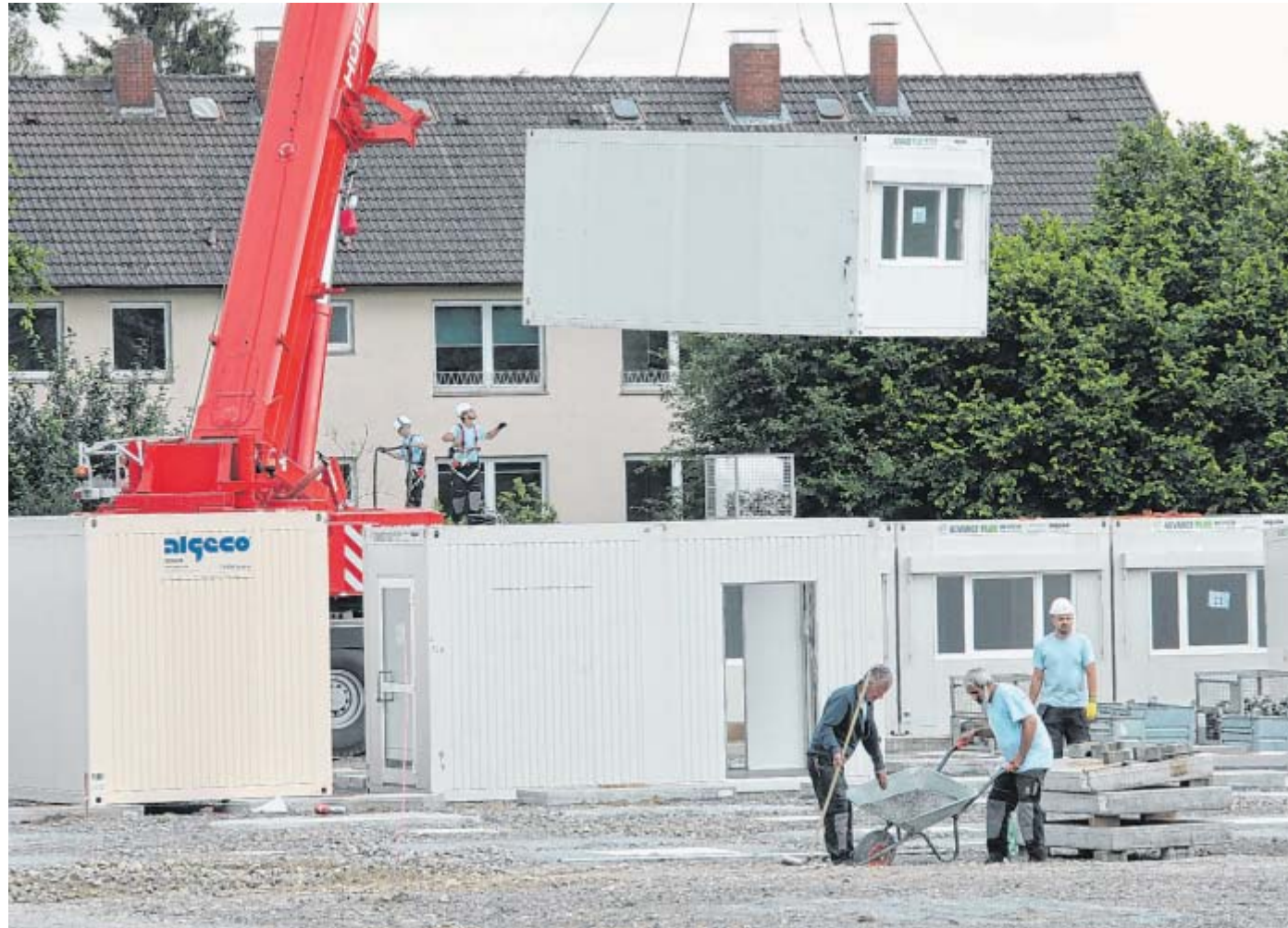
Wohnraum am Haken: Seit dem gestrigen Montag werden 342 Container für die Studierenden der Fachhochschule für Finanzen auf dem Bildungscampus aufgestellt. In sechs Wochen sollen die Wohneinheiten stehen und bis Anfang September bezugsfertig sein. FOTO: PETER STEINERT
