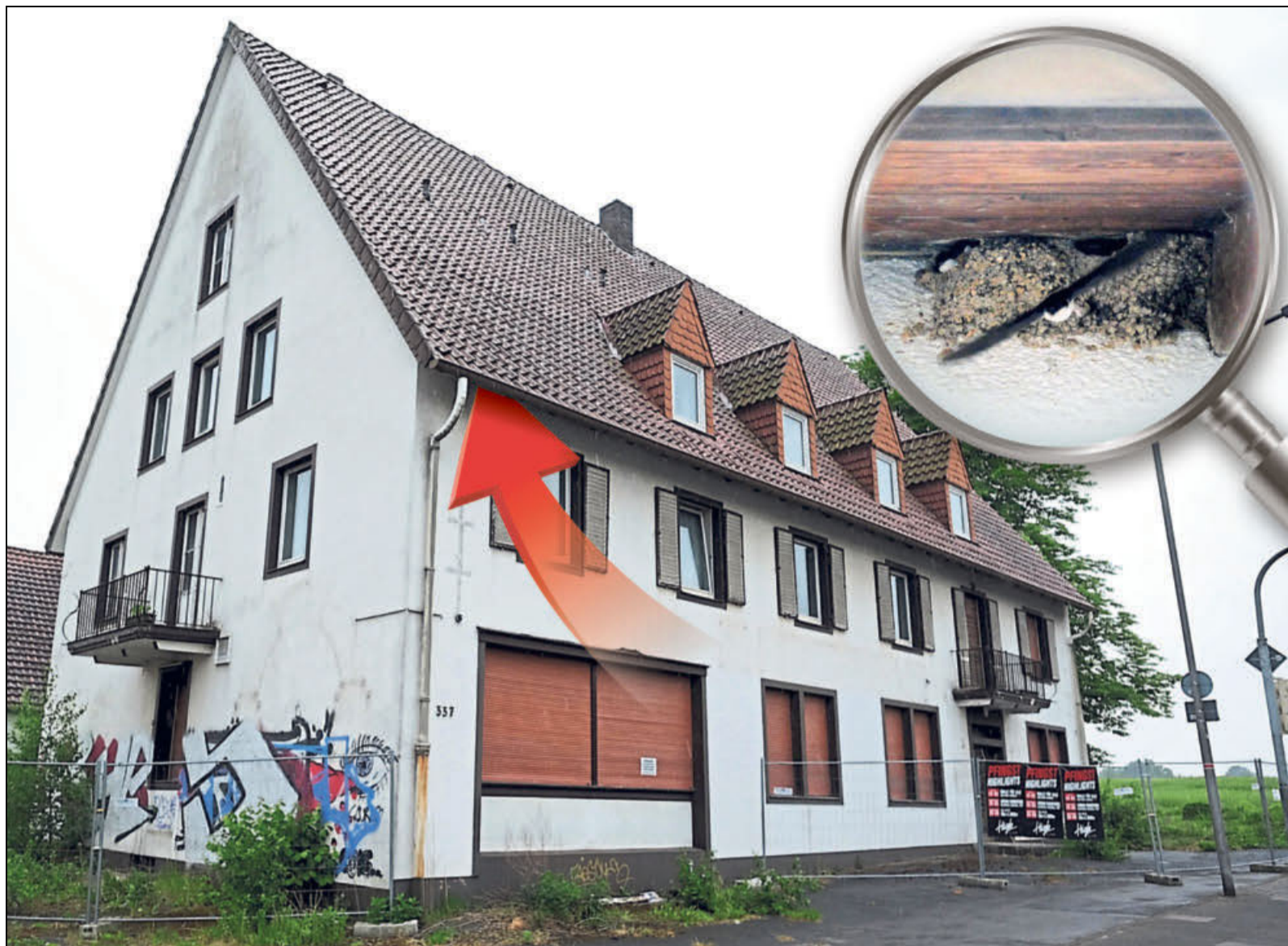
Unter dem Dach des alten Ehrler-Hotels in Elverdissen nisten Schwalben. Insgesamt haben die Vögel vier Nester gebaut. Weil die Tiere unter Schutz stehen, darf das Gebäude erst nach der Brutzeit im Herbst abgerissen werden. Fotos: Moritz Winde/Montage: Patrick Sönel
