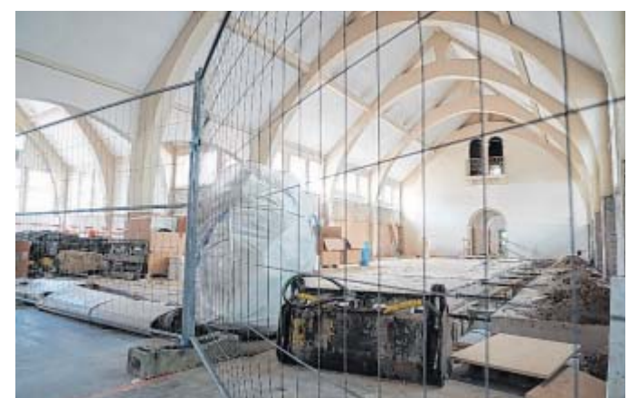
Einblick: Auf dieser Seite der Markthalle sollen bis Ende des Jahres fest installierte Marktstände stehen.
