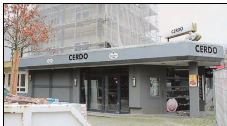
An der Baustelle des Brandhauses am Lübbertor könnte bald gearbeitet werden. Baumaterial wurde in den letzten Tagen bereits abgeladen, für die Baugenehmigung fehlen nach Aussage der Stadt aber weiter Unterlagen Foto: Ralf Meistes
