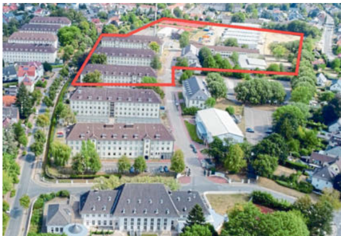
Der rot umrandete Bereich wurde von der Stadt erworben. FOTO: SEH
