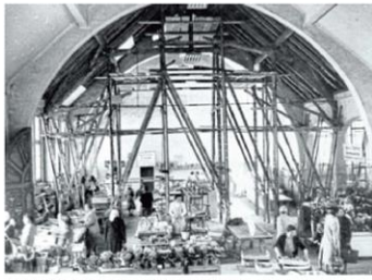
Sicherheit 1960: In der Herforder Markthalle werden unter laufendem Betrieb Kriegsschäden behoben.
