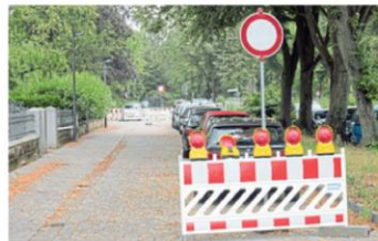
Neu: In einem ersten Schritt war der künftige Straßenverlauf angelegt worden, der von der Mitte des Wilhelmsplatzes zur Nordseite gewandert ist. FOTO: PETER STEINERT
